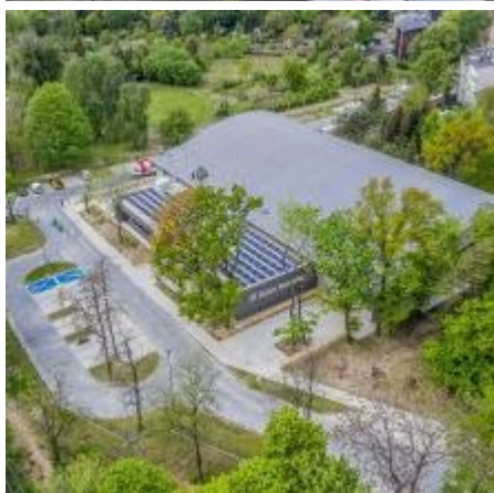
• Ul na dachu Basenu Burowiec
